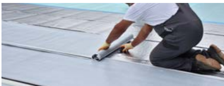
Polaganje drugog sloja dvostrano samoljepive hidroizolacije FIBRANhydro SEISMIC T-1,8sk/sk na prvi sloj FIBRANhydro ANTI RADON 1,5sk . Polaganje se vrši u istom smjeru, ali s izmaknutim spojevima. Silikonska zaštitna folija uklanja se postupno tijekom polaganja hidroizolacije.
