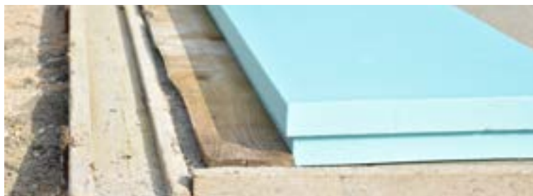
Uredno izveden podložni beton kako bi ploče FIBRANxps 400-L , što bolje sjele na ravnu podlogu.
