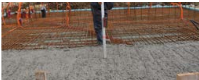
Slijedi postava armature na distancere i betoniranje. SEISMIC temeljni jastuk spreman je za daljnje radove zidanja, betoniranja i montaže.
