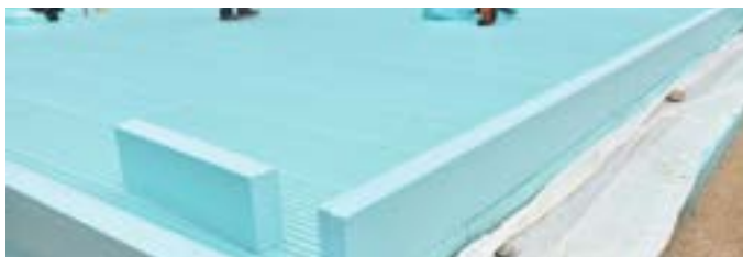
Po završetku izvedbe SEISMIC sustava, pristupamo izvedbi oplata pomoću FORM elemenata.
