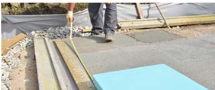
Precizno pozicioniranje i polaganje prvog sloja FIBRANxps 400-L (500L, 700-L) toplinske izolacije.
