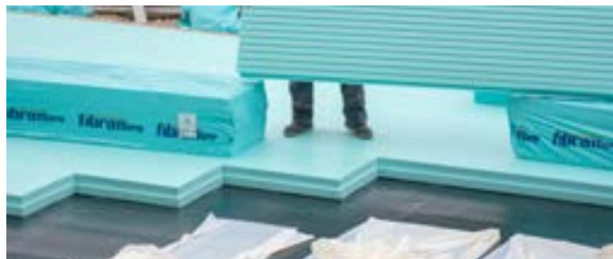
Drugi sloj toplinske izolacije FIBRANxps SEISMIC polaže se poprečno na položenu HI. Silikonska zaštitna folija odstranjuje se postupno.
