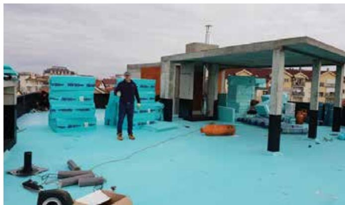
Pad ploha prema kanalicama i slivnicima, izведен je od XPS-a rezanog u nagibu, kojeg nazivamo FIBRANxps INCLINE, uz osnovnu toplinsku izolaciju od XPS-a debljine 36 cm. Kako su raspoređeni slojevi krova, opisano je uz donju fotografiju dijela gotovog krova s opločenjem.
