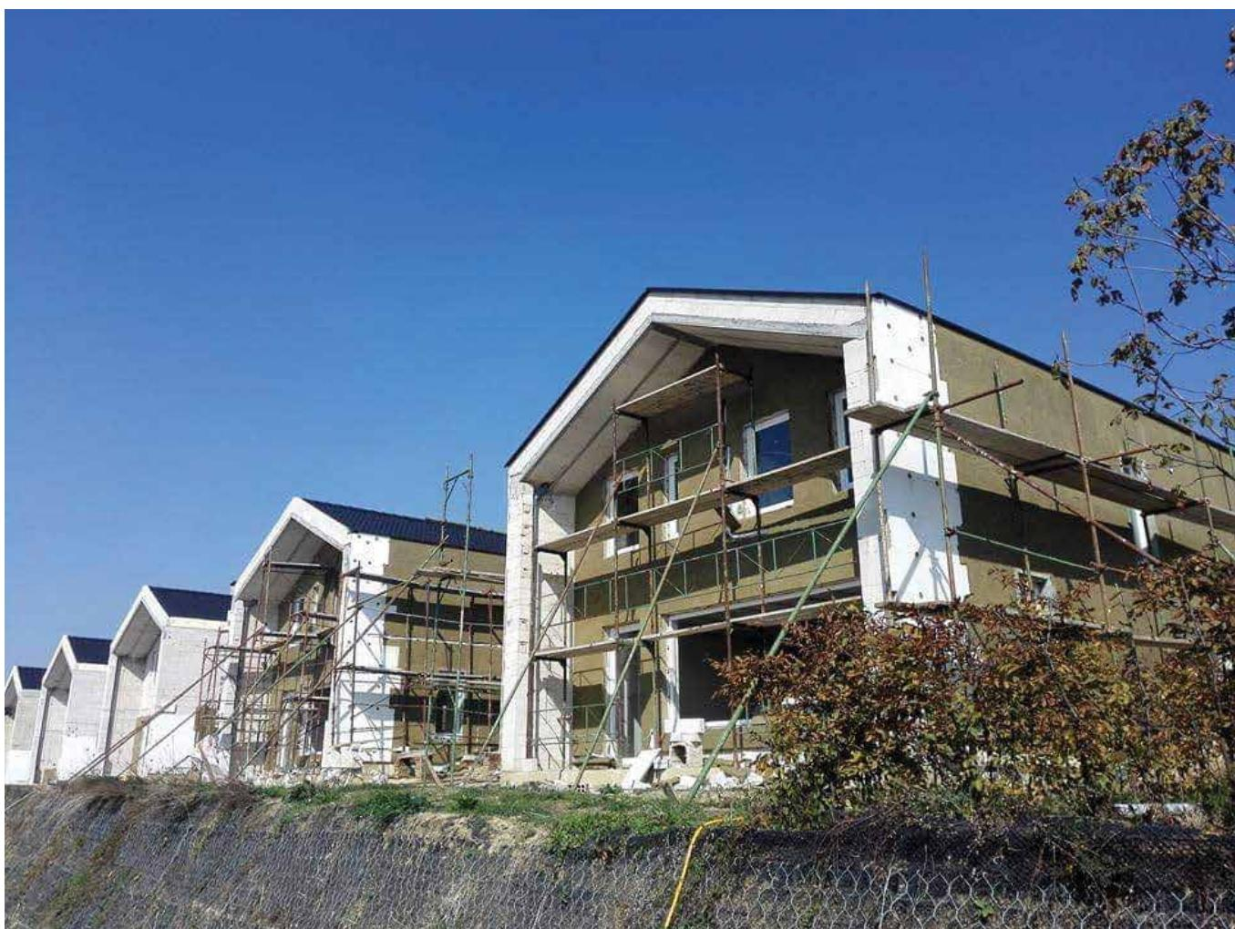
Urbane su vile građene blokovima od plinobeotna koji su sami po sebi dobar toplinski omotač zgrade. No uz to je na ovim objektima ugrađen ETICS sustav na kamenoj vuni **FIBRANGEo** Etics plus, debljine 10 cm. Kratica ETICS znači sustav vanjske toplinske izolacije (External Thermal Composit System), što se u potpunosti uklapa u način niskoenergetske gradnje.
