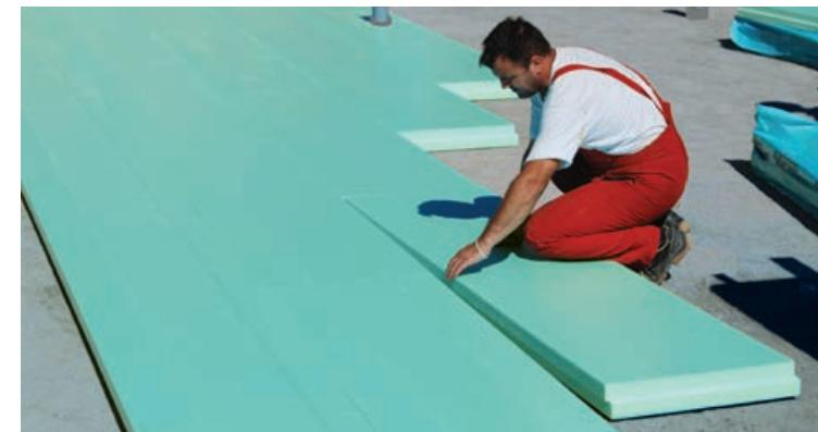
Prije ugradnje podložnog betona i prvog sloja FIBRANxps toplinske izolacije, potrebno je posvetiti posebnu pažnju instalacijama. Na precizno položeni prvi sloj FIBRANxps toplinske izolacije odgovarajuće debljine, polaze se i lijeplji samoljepljiva hidroizolacija.
