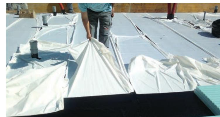
Na zalijepljeni sloj dvostrano lijepljive hidroizolacije postavimo oplatu temeljne ploče. Postupno uklanjamo zaštitnu foliju s hidroizolacije i na nju polažemo FIBRANxps SEISMIC ploče s osobitom pažnjom i preciznošću. Zbog snažne lijepljivosti vrlo je teško korigirati krivo položenu ploču, stoga treba raditi polako i precizno. Prije ugradnje armature, eventualne procepe između ploča zapunimo PU pjenum. Slijedi polaganje armature na distancerima i betoniranje.
