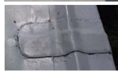
Budući da je rub krova izведен plitkim betonskim profilom, TPO se zaliјepio i prilagodio betonskom profilu, a okapi su izvedeni od pomicanog lima koji je tvornički kaširan ovim materijalom, kako bi se omogućilo termičko spajanje membrane na limarski detalj. Izolacija je svijetle boje, čime se pridonosi manjem zagrijavanju krova, djeleći čišće i urednije, a osim toga pogodna je za eventualne popravke u budućnosti.
