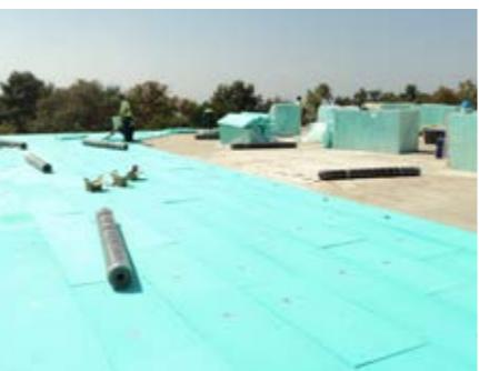
koja se nalazi ispod hidroizolacije, a koja nije zaštićena parnom branom ili se parne može odzračivati, te se tako nemajući kamo van, vraća najkraćim putem natrag – kroz nosivu (najčešće betonsku) konstrukciju u unutarnji prostor. U ovakvima slučajevima potrebno je skinuti postojeću hidroizolaciju, ukloniti navlaženu toplinsku izolaciju i zamijeniti ju novom, suhom, nakon što se očistila i kvalitetno izvela nova parna brana s odzračivanim parorasteretnim slojem. U ovom slučaju govorimo o
