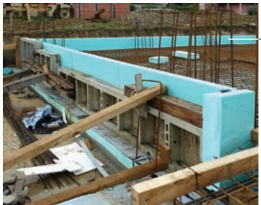
Lijevanje betona unutar vertikalnih elemenata od XPS-a dodatno je olakšalo izvedbi oplate temeljne ploče.
