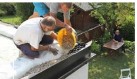
Pažljiva ugradnja svih komponenti garancija je kasnijeg ljepšeg izgleda, ali i trajnosti svih funkcionalnih dijelova zelenog krova. Rubna odvodnja kroz drenažni šljunak, iznimno je važna u slučajevima naglih i obilnih kiša, da ne bi došlo do neželjenog preljevanja vode.
