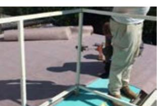
Budući da je PVC membrana ugrađena iznad toplinske izolacije od XPS, bilo je potrebno ugraditi razdjelnji geotekstil između hidro i toplinske izolacije.
