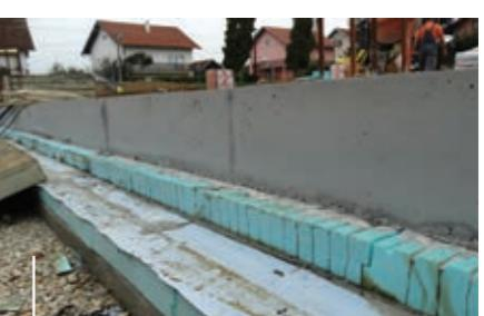
Spoj betonske ploče i Seismic ploče. Lijevan beton popunio je kanalice na FIBRANxps Seismic ploče, čime je spoje dva elementa izveden bez klizne ravnine između njih.
