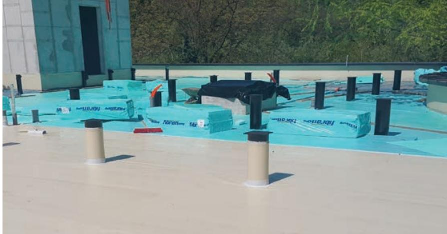
Budući ozelenjeni krov na kojem je primijenjen princip FIBRANxps DUO-OPTIMO SkinSeal krova.
