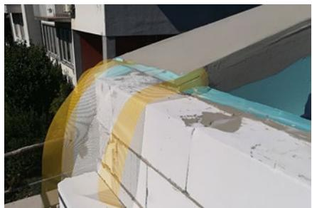
Postojeća atika nije bila dovoljne visine za izvođenje 24 cm toplinske izolacije, plus minimalnih 15 cm od završne kote krova do gornjeg ruba atike. Stoga se atika nadozidala, uvezši u obzir sve specifičnosti konkretnog krova. To je omogućilo izdubu slijedećih slojeva (gledano izvana, prema unutra):
