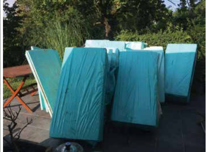
Puno dvorište odpada uskoro je očišćeno, a na mjesto stare toplinske izolacije, već će čekala nova, suha i puno veće debljine.
