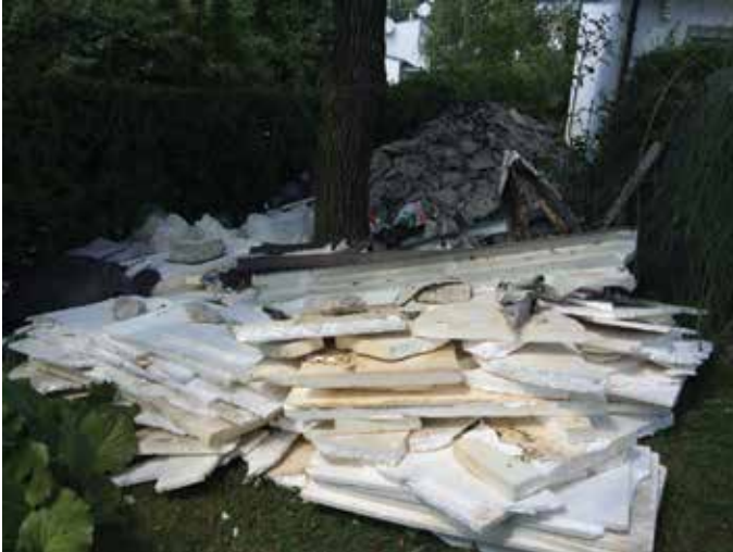
Puno dvorište odpada uskoro je očišćeno, a na mjesto stare toplinske izolacije, već će čekala nova, suha i puno veće debljine.
