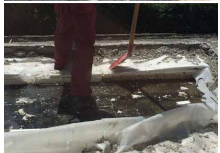
Nakon skidanja keramičkih pločica, prvi se sloj glazure mrvio, no onaj ispod njega je bio „tvrd orah“.
