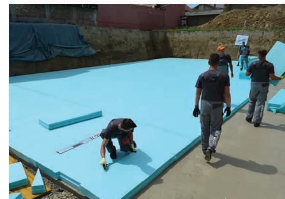
Ukratko, došli su do zaključka da se na tvrdim tlima, mogu izvesti zgrade do visine 3 etaže, a na manje nosivim tlima do 2 etaže. Najmanja tlačna čvrstoća XPS ploča koja se preporučuje za izvedbu Seismic temeljnog jastuka je 400 kPa. Na mekšim tlima je moguća izvedba i na pločama tlačne čvrstoće 500 i 700 kPa.
