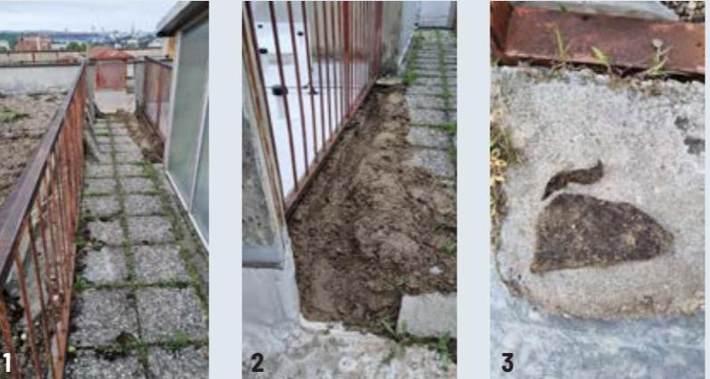
Budući da u šuti ima cementa, a i pH pijeska može biti visoko lužnat, očito su ovi uvjeti nepovoljno utjecali na hidroizolaciju, koja je procurila upravo tamo, gdje je trebala biti najzaštićenija.
