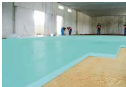
Toplinska izolacija poda u skladišnom objektu FIBRANxps 300-L pločama.
