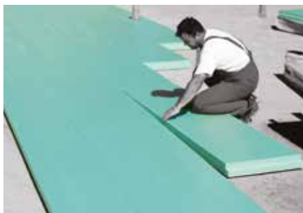
Prije ugradnje betona i prvog sloja toplinske izolacije FIBRANxps ( 400-L , 500-L , 700-L ) posebnu je pozornost potrebno obratiti na instalacije. ( www.fibran.si )
