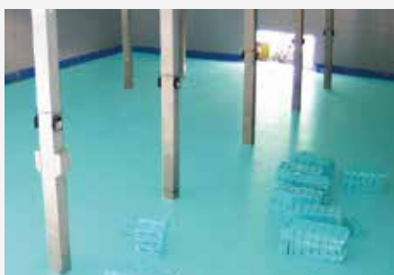
Toplinska zaštita hladnjače FIBRANxps 500-L , 700-L .
