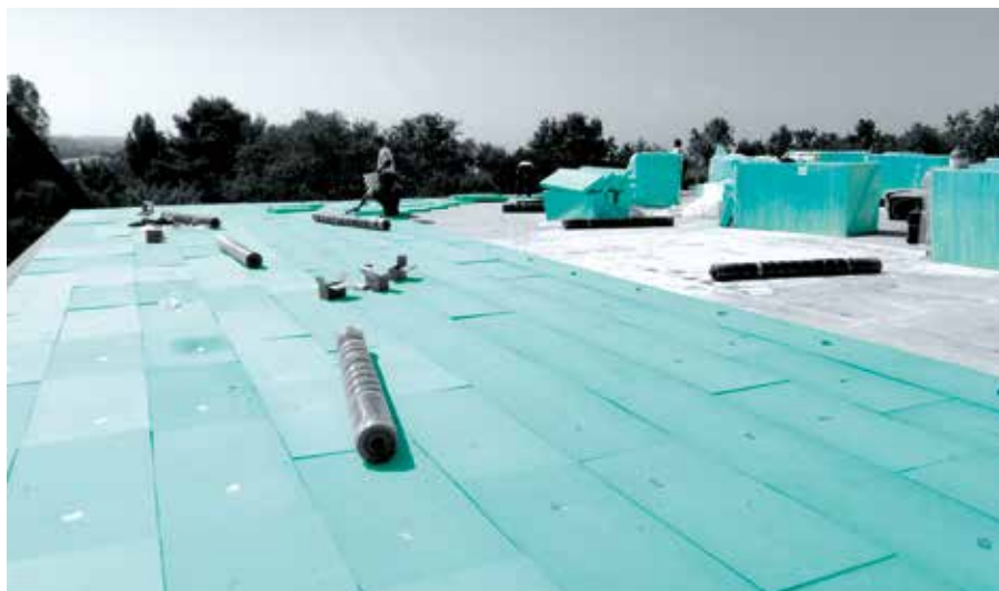
Povećanje krovnog nagiba građevine pomoću FIBRANxps INCLINE ploča, uz istovremenu sanaciju toplinske izolacije ravnog krova.
