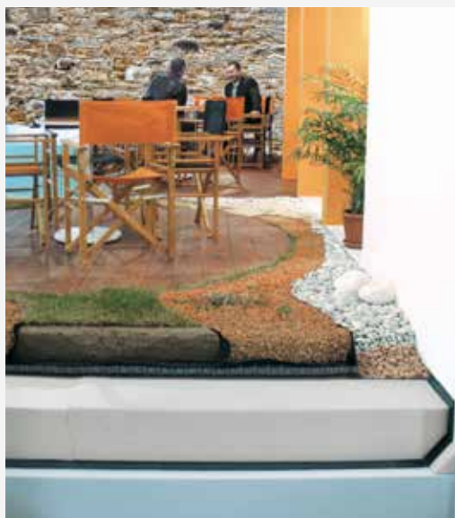
OPTIMO SKIN SEAL krov s FIBRANxps INCLINE i FIBRANskin SEAL (membranom, koja pospješenom odvodnjom omogućuje krovu dodatnu toplinsku učinkovitost).
