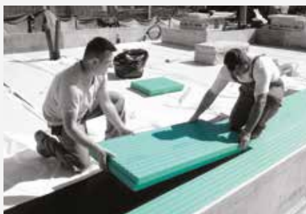
Ploče FIBRANxps SEISMIC polažemo polako i precizno na ljepljivu hidroizolacijsku površinu.
