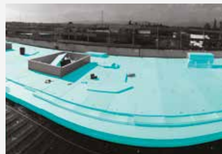
Izvedba nagiba FIBRANxps INCLINE pločama i pričvršćenje FIBRANxps ploča u slučaju mehanički učvršćenog krova, bez opterećenja.
