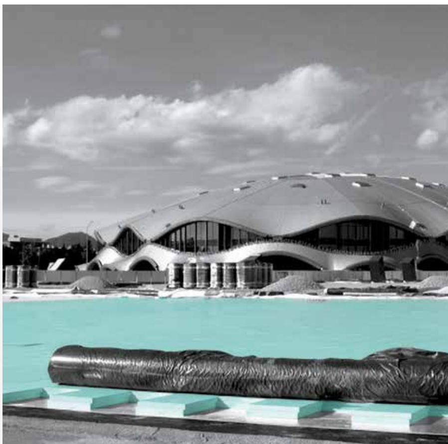
Toplinska zaštita ravnog krova različitih završnih obloga FIBRANxps pločama različite tlačne čvrstoće.
