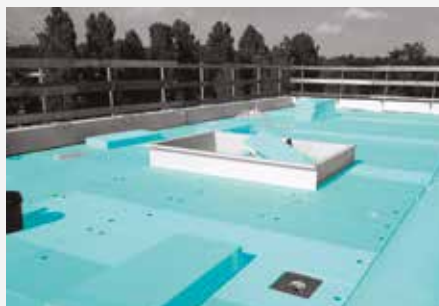
Izvedba nagiba FIBRANxps INCLINE pločama i pričvršćenje FIBRANxps ploča u slučaju mehanički učvršćenog krova, bez opterećenja.
