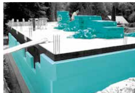
Tvrda, vodoneupojna izolacija FIBRANxps 300-L mehanička je zaštita hidroizolacije i trajna toplinska zaštita podzemnog dijela objekta, također i u slučaju visokog nivoa podzemne vode.
