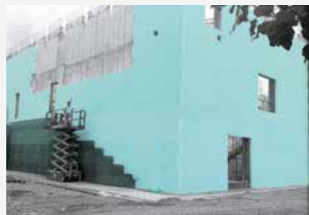
FIBRANxps MAESTRO kao sendvič izolacija; faza izrade vanjskog dijela fasade od vidljivog bijelog betona.
