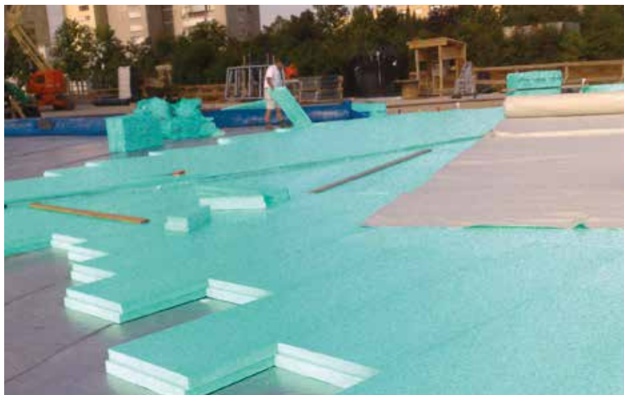
Izvedba obrnutog ravnog krova s toplinskom izolacijom FIBRANxps 300-L; mogućnost potpunog iskorištenja krova.
