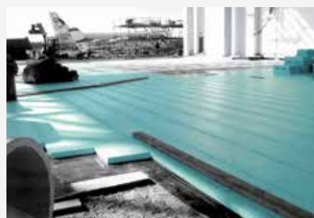
Toplinska zaštita poda u aerodromskom hangaru FIBRANxps 700-L .
